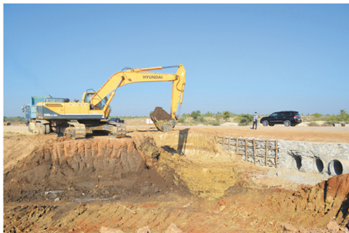
၂၀၂၀ ခုနှစ်တွင် တံတားဦးလေဆိပ် (စကားအင်းအိုင်) မှ ဗြူသာစက်မှုဥယျာဉ်သို့ 35km အရှည်ရှိ အိုင်အမာမြေသားလမ်း Box Culvert များ ထည့်သွင်း တည်ဆောက်နေစဉ်
